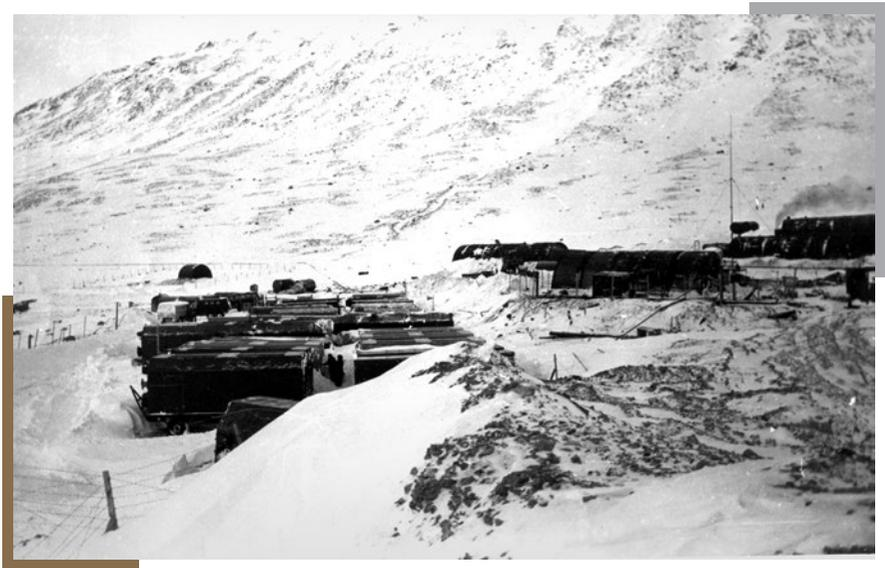
аппаратурных комплекса НИИИТ, перемещённые лавиной примерно на 1,5 км и несколько раз перевёрнутые, оказались «на плаву» на поверхности языка лавины.
